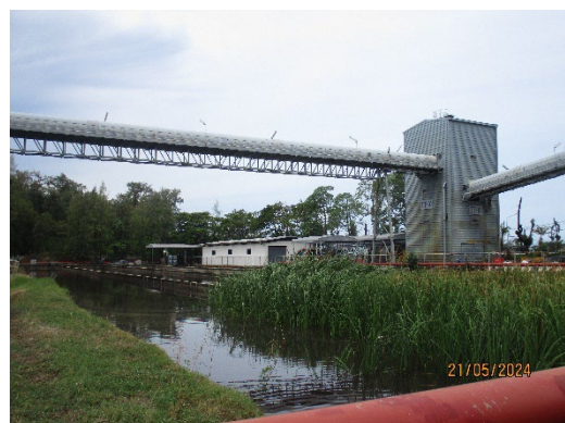
ภาพที่ 2-6 บ่อตกตะกอน (Run off pond) สำหรับบำบัด น้ำเสียจากกิจกรรมการขนถ่ายถ่านหิน
